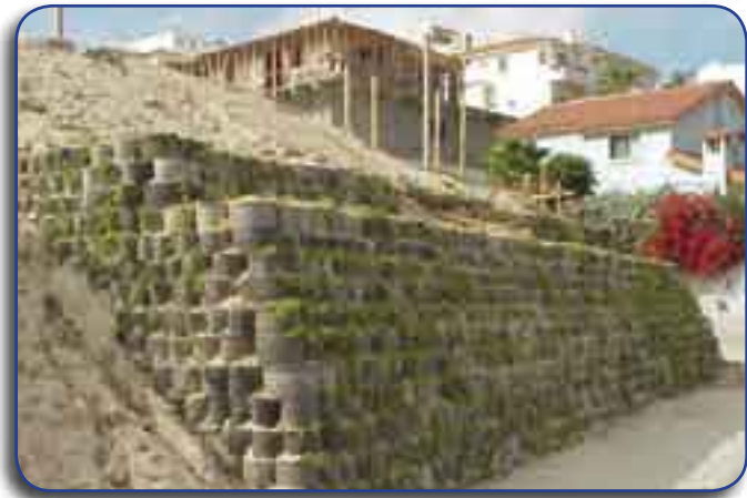
Muro de llantas enteras para evitar la erosión del suelo. Foto cortesía de la Comisión Estatal de Servicios Públicos de Tecate
