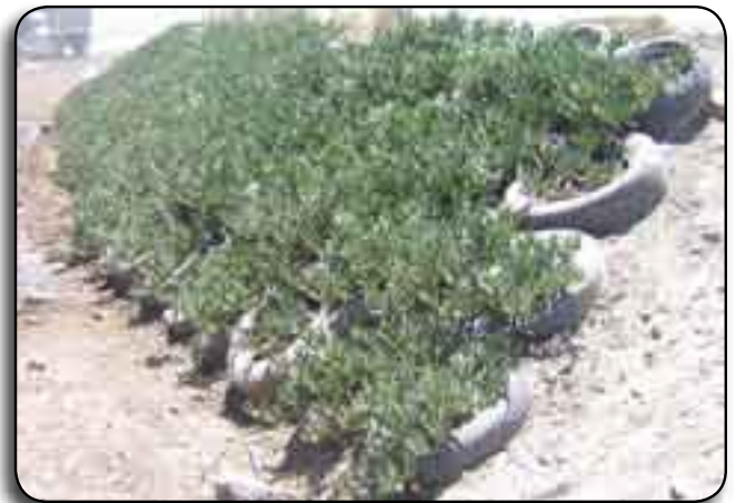
Muro de llantas para el control de la erosión en Los Arroyos, México
