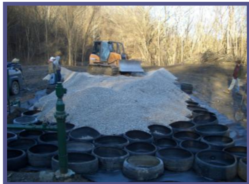
Imagen 8.9. Camino de servicio del Pozo de Gas Sorbello de Bowie, Inc. en Clarksburg, WV (REAGCO, 2011).
