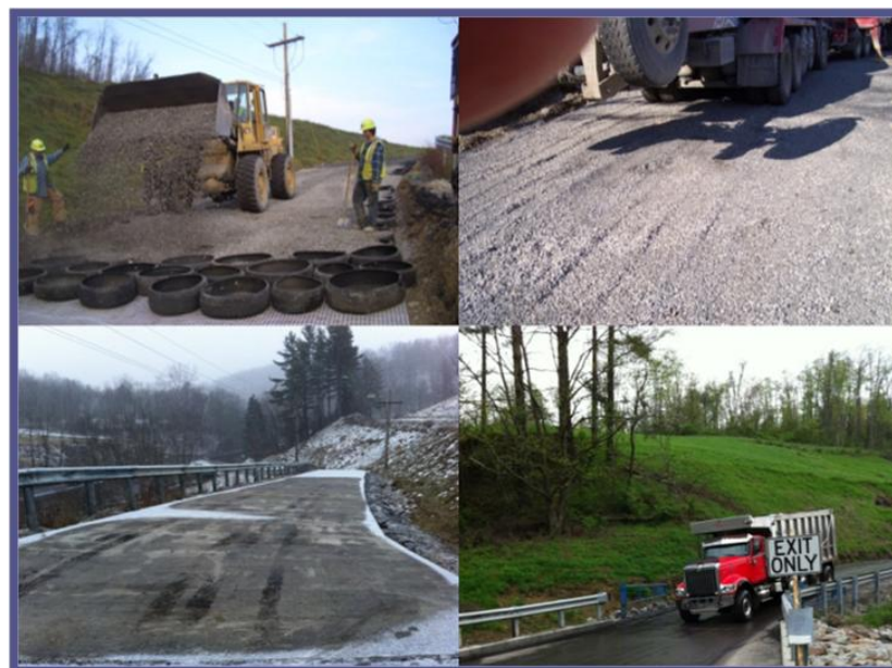
Arriba izq.: colocación de los cilindros; arriba der.: elaboración de la pendiente; abajo izq.: camino terminado; abajo der.: camino en uso.
